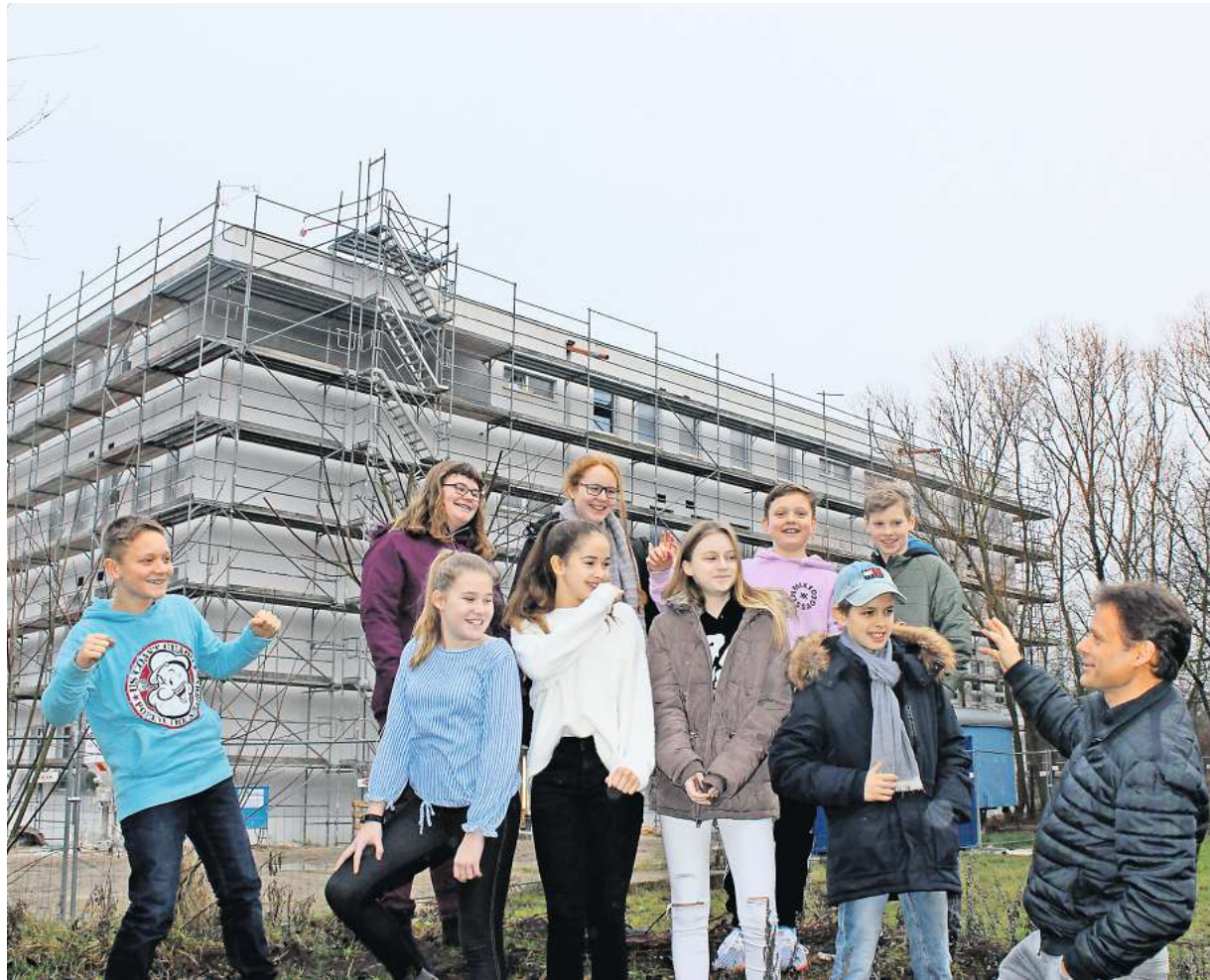
Die Montessorischule vergrößert sich, im Sommer 2019 soll der viergeschossige Neubau fertig sein.
